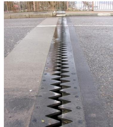
Fig. 4.12: Dehnungsfuge einer Brücke
